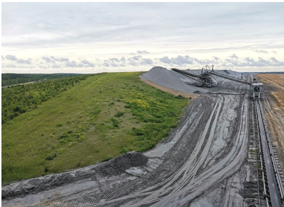
Рис. 1. Участок сухого складирования золоотвала № 2 через 8–12 лет после биологического этапа рекультивации, 2025 год
